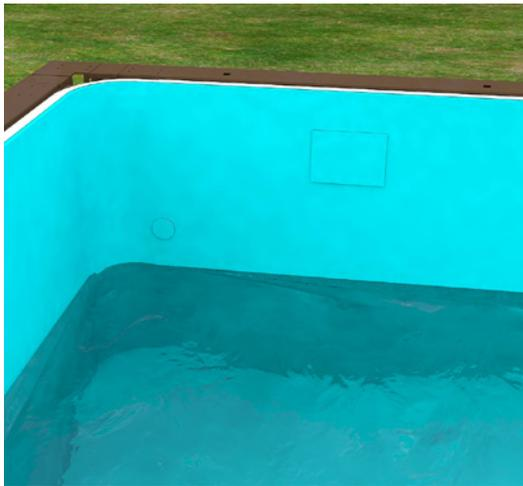
Después de la colocación del liner y de llenada su piscina hasta 30cm de altura a contar del medio de la boca del skimmer, deberá localizar las juntas previamente colocadas sobre la boquilla de impulsión y del skimmer.
