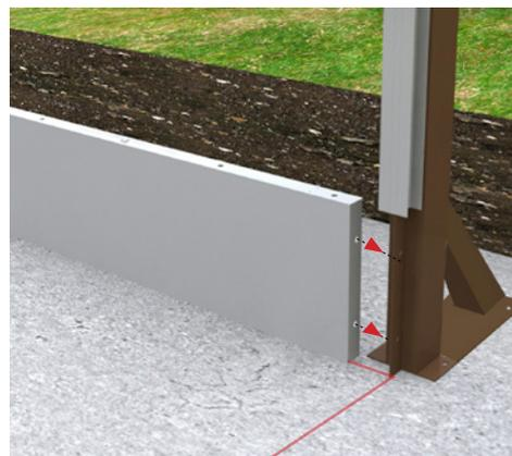
La instalación de la estructura se inicia por la esquina de la piscina **(A)**. Coloque correctamente el pilar como se indica en imagen y a continuación coloque el panel de estructura base.
