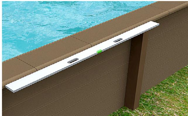
Durante la fijación del borde es necesario comprobar el nivelamiento
