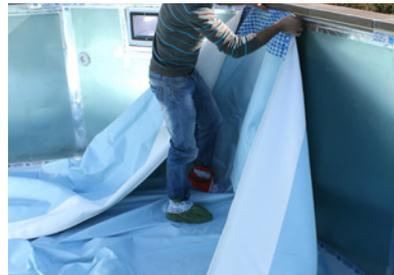
Inserta horizontalmente el rebordo del liner en el soporte de encaje en PVC. El liner quedara inmediatamente colocado cuando se encuentre posicionado verticalmente.
