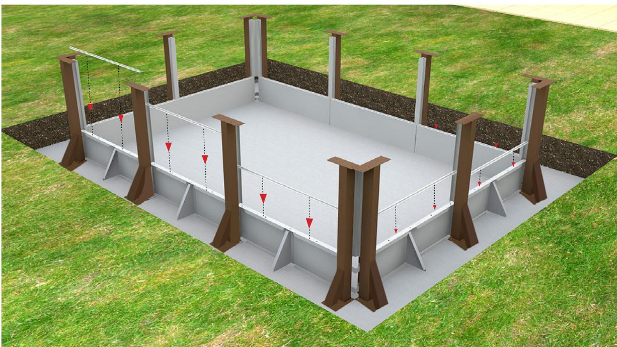
Proceda a la fijación de los perfiles utilizados en todas las perforaciones para el efecto. Repita el procedimiento en todo el perímetro de la piscina.
