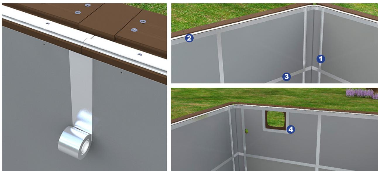
Después de atornillados los paneles, aplique la cinta de aluminio para ocultar la cabeza de los tornillos **(1)**. Aplique cinta de aluminio entre los paneles de acero y las piezas en metal de soporte de borde **(2)**, de la misma manera que lo deberá hacer en la unión de los paneles de acero y de la estructura de base. **(3)**. Utilice el mismo procedimiento para colocar la cinta de aluminio en las uniones de los paneles del equipamiento **(4)**.
