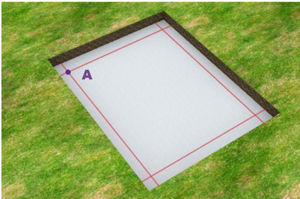
Después de efectuada una correcta marcación del trazado de la piscina, ha llegado el momento de iniciar el montaje de la estructura a través de la colocación de los pilares de esquina. Elija una de las esquinas de la piscina para empezar la colocación de la estructura.
