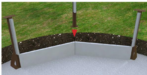
Instale los dos paneles entre los pilares **A** y **C** para obtener la localización del pilar intermedio. Proceda de la misma manera para obtener la localización de los pilares intermedios entre **D/B**, **B/E** y **F/A**
