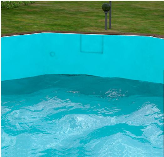
Después de la colocación del liner y de llenada su piscina hasta 30cm de altura a contar del medio de la boca del skimmer, deberá localizar las juntas previamente colocadas sobre la boquilla de impulsión y del skimfiltro.
