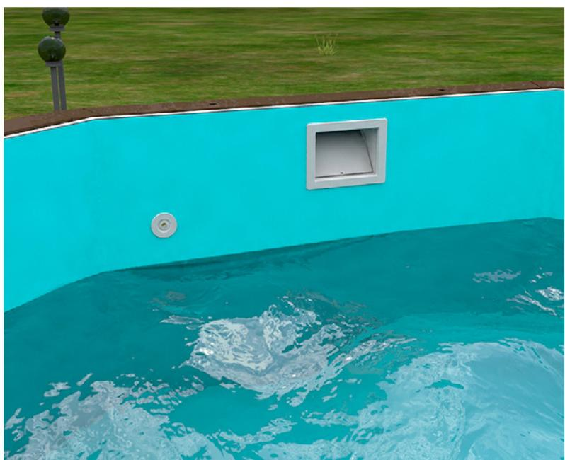
Una vez terminada la colocación y el atornillamiento de las bridas, de la boquilla de impulsión y del skimfiltro, coloque el espejo, tal como lo indicamos en las ilustraciones.
