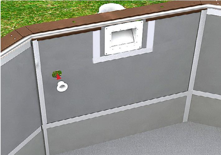
La boquilla de impulsión es colocada en la perforación denominada para esse efecto.
