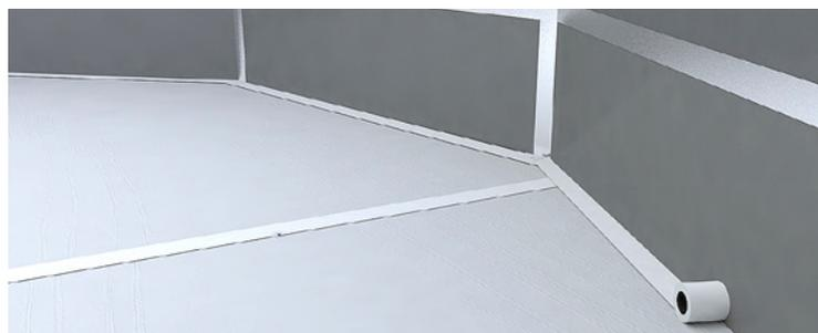
En seguida, coloque las diferentes piezas, bien alargadas, en el fondo de la piscina, sin que las mismas se sobrepongan y termine con la aplicación de la cinta adhesiva sobre las uniones de los diferentes elementos. También aplique la cinta adhesiva alrededor de la piscina sobre la alfombra y la pared de acero.
