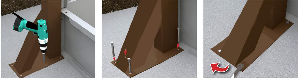
Perfore el hormigón con un berbiquí, utilizando la perforación existente en la base de los pilares. Repita este procedimiento para la estructura. En seguida fije o pilar de la losa usando los bujes de metal suministrados en el kit.
