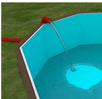
Asegúrese que el liner esta correctamente colocado y no presenta pliegues. Si permanecen visibles pequenãs pliegas, debera ayudar el liner a se posicionar correctamente en el momento de llenar su piscina. Pare de llenar la piscina cuando vea que el nivel del agua se encuentra a 30cm del medio de la boca del skimfiltro. Una vez el nivel del agua llegue a la altura pretendida y despues de parar de llenar la piscina, coloque las juntas de sujección e las bridsa de sello de las piezas de empotrar.
