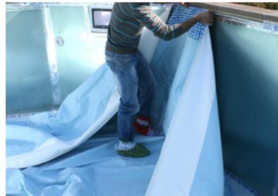
Insiera horizontalmente el rebordo del liner en el soporte de encaje en PVC. El liner quedara inmediatamente colocado cuando se encuentre posicionado verticalmente.
