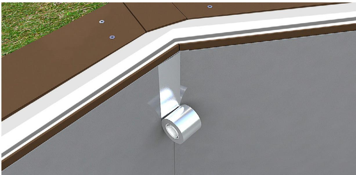
Después de atornillados los paneles, aplique la cinta de aluminio para ocultar la cabeza de los tornillos **(1)**.
