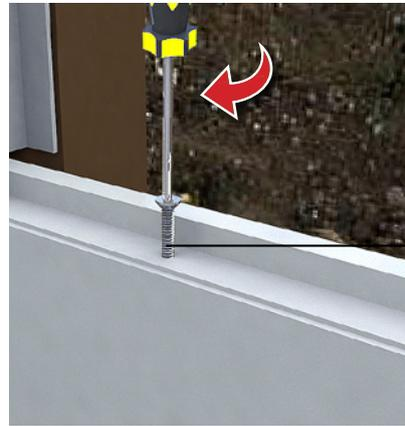
Después de posicionar el perfil de aluminio en el panel de la estructura base, vea se es evidente que la perforación del perfil esta alineada con la perforación que existe en la parte de arriba del panel. Use las perforaciones descritas para fijar el perfil a la estructura de base utilizando los tornillos que le disponibilizamos en el kit.
