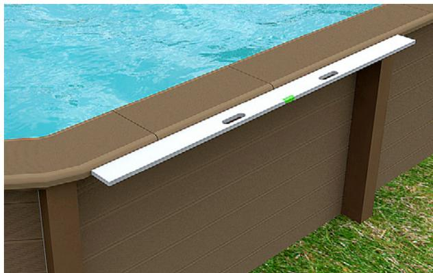
Durante la fijación del borde es necesario comprobar el nivelamiento
